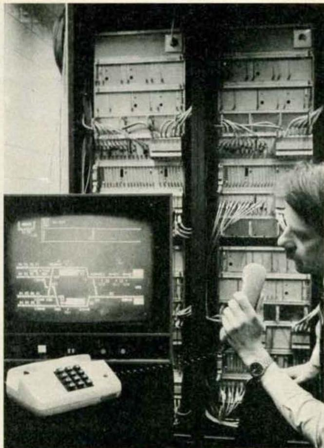
signaux au poste d'aiguillage. Pour atteindre la fiabilité absolue, tous les micros du système «Simis» sont doublés. Il est en outre possible de raccorder un poste d'aiguillage électronique à un autre ou à un système hiérarchiquement
