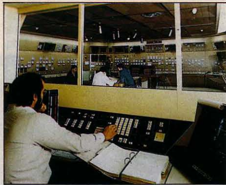
Le centre d'instruction de la centrale nucléaire de Paluel.
