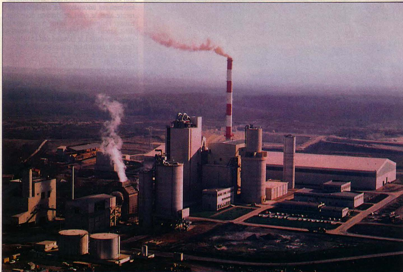
Vue aérienne du démarrage du chantier d'extension de l'usine de Bussac.
